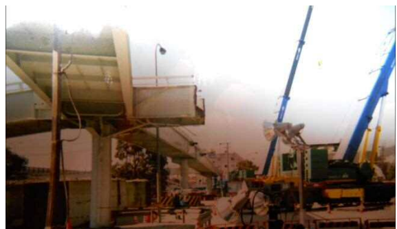
鋼桁橋梁 切断中
