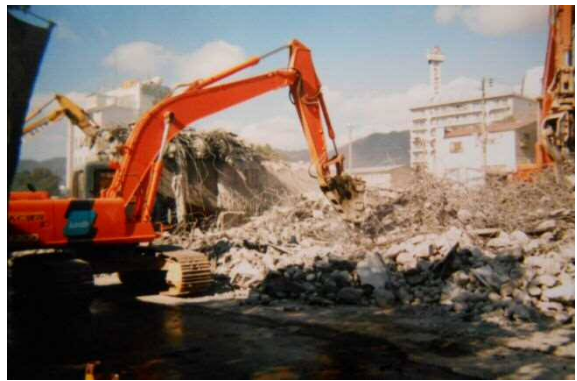
岩屋高架橋 撤去作業中
