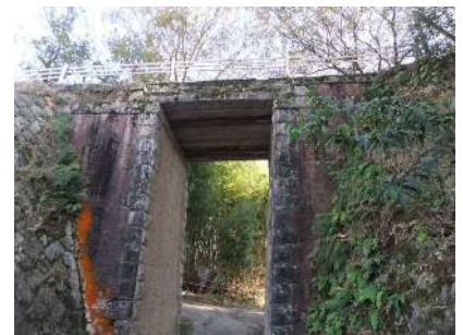
煉瓦積み橋台
