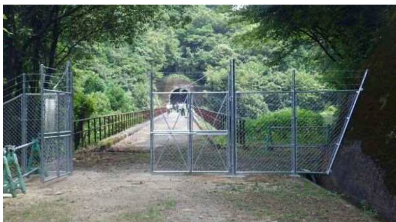
写真.4 下長屋トンネル手前のフェンス
