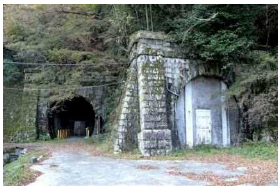
旧逢坂山トンネル東側坑口
