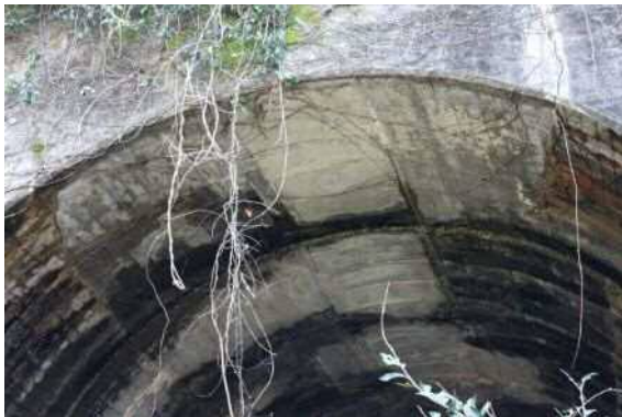
旧線トンネルの天井部
