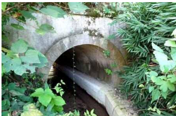
山陰本線島田川暗渠
