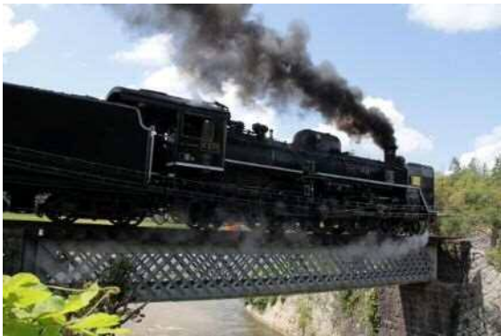
ラチス桁（徳佐川橋梁）
