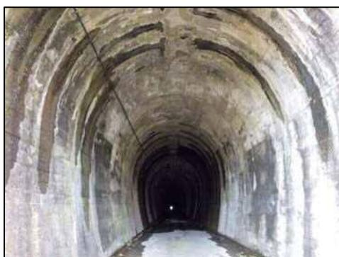
写真10 老朽化が進む生子トンネル
