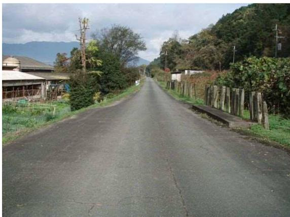
線路敷：舗装され、平成 26 年までバス専用道として使用された。脇に柵代わりに枕木が立てられている。
