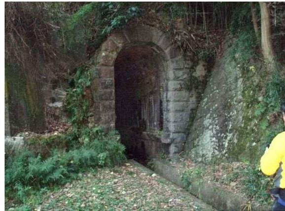
鹿川隧道(石積):アーチ部の小さい半径も石積で構築されている(幅2mくらい)。
