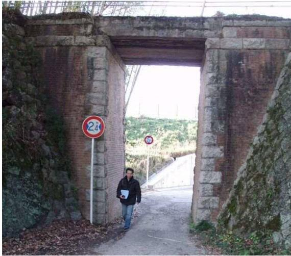
赤橋(石積+レンガ):橋台は角の部分のみ石積で大部分はレンガ。上部工は石(橋長3mくらい)。路盤は舗装されており、この上を車が通行していたと考えられる。
