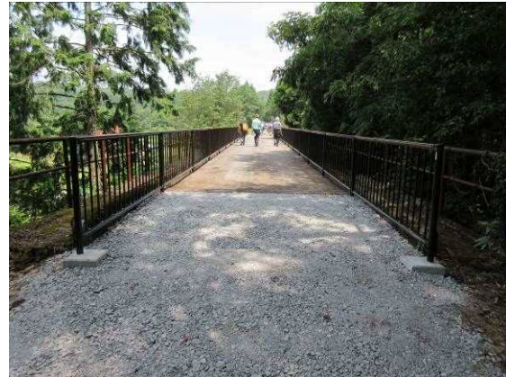
写真 6.4 現在の状況（補修後）
