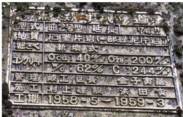
写真 5.11 トンネル銘板
