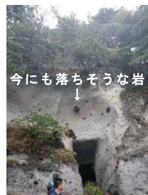
トンネル入口の頭 上にある岩
