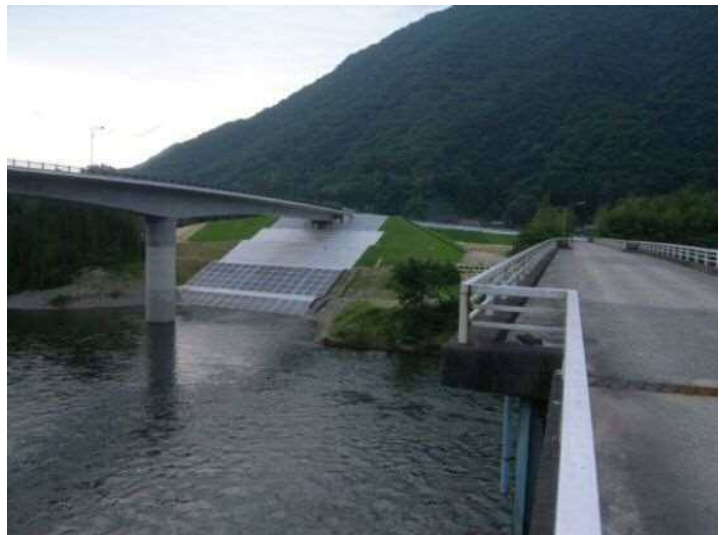
▲ 3 代目川越大橋（左側）と 2 代目川越大橋（右側）
