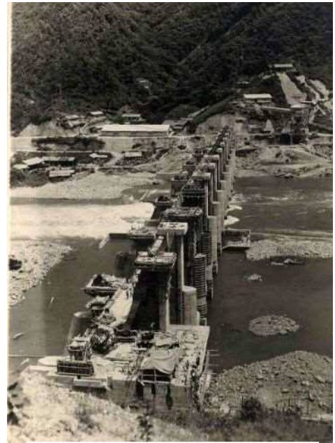
写真 2 建設中の浜原ダム
