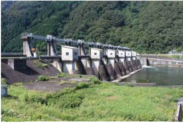
写真 1 浜原ダム下流側全景
