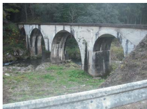
・土木学会選奨土木遺産認定のアーチ橋 ※実測対象橋梁
