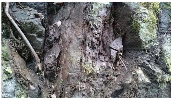
写真3 断層岩(カタクレーサイト)の露頭
