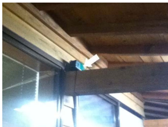
写真 1 管理等屋根下(地点①)
