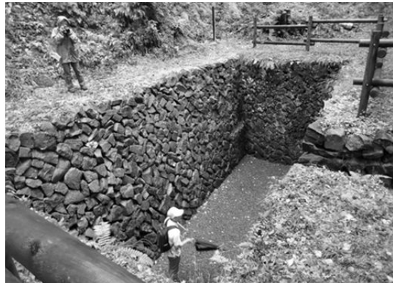
写真 10 別所氷沢風穴 露天の雑石積みである。
