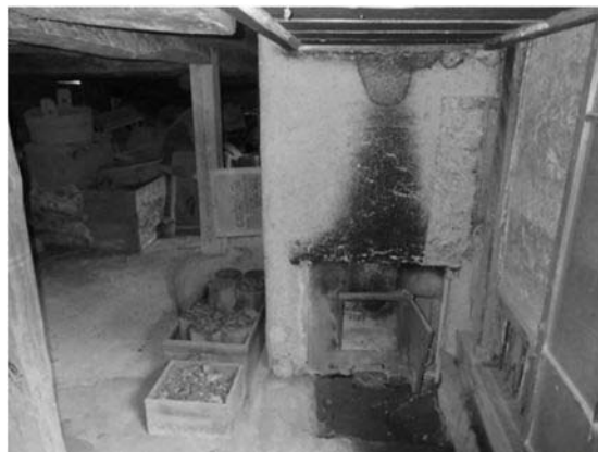
写真4 蚕屋地下の暖房装置 ここで火を焚いて温風を送る。
