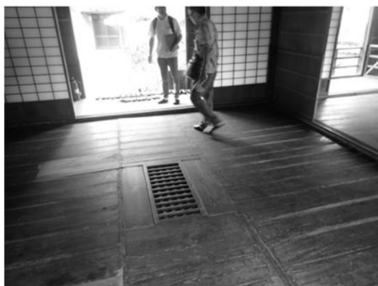
写真5 蚕屋の養殖部屋 格子部から温風が出る。
