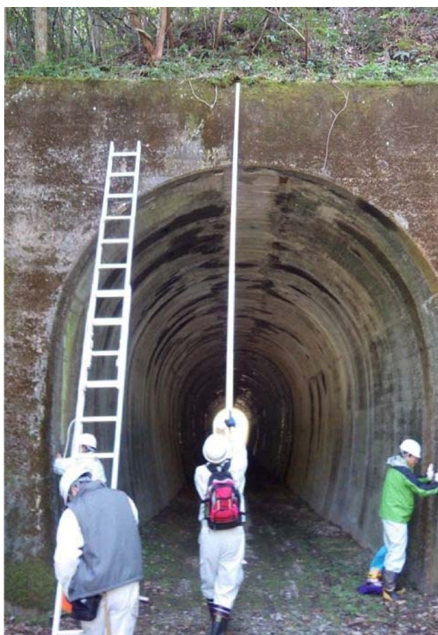
写真.2 今福第4トンネル実測・シュミットハンマー調査状況
