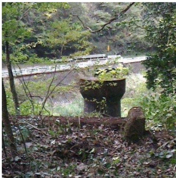
写真.9 有福第3トンネルから県道田所国府線を望む
