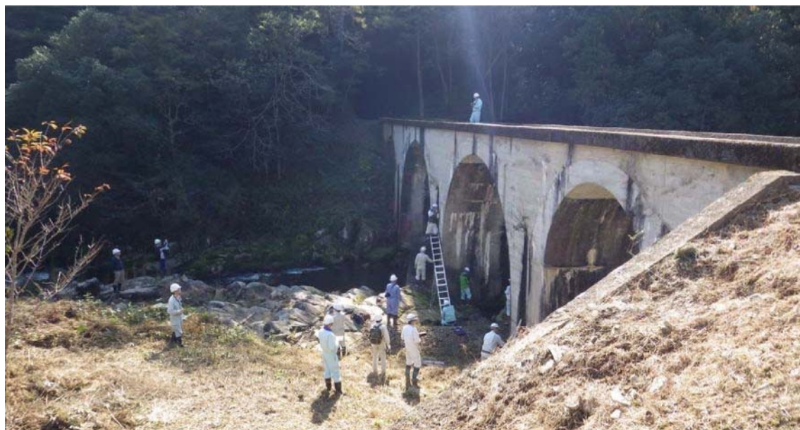
写真.1 4連アーチ橋実測状況
