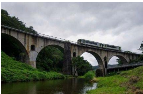
宮守川橋梁 (釜石線)
