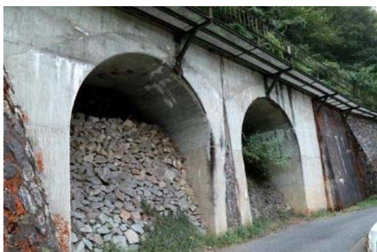
三江線の無筋コンクリートアーチ橋
