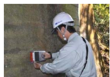
写真—8、鉄筋有無調査
