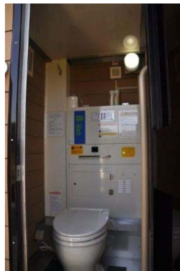
写真—16、バイオトイレ
