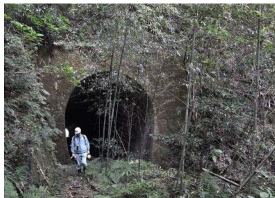
写真一 9、有福第 3 トンネル南口
