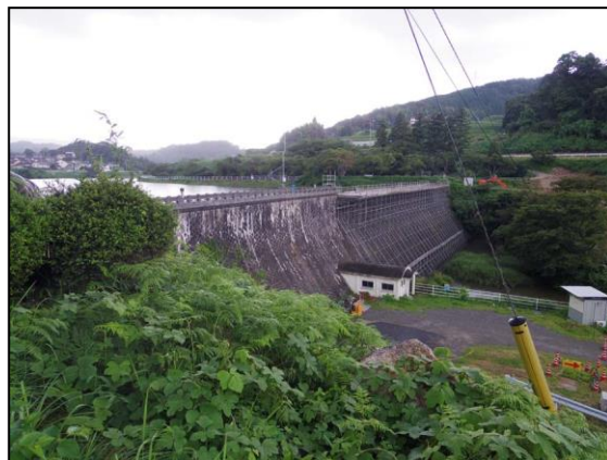
千本ダムは耐震工事のため足場が組んでありました
