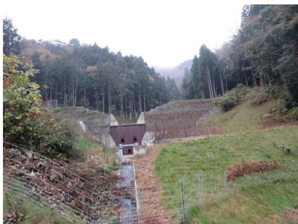
ソイルセメントにより築造された堰堤
