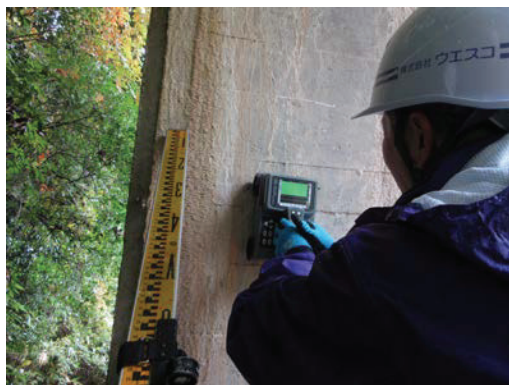
【RCレーダーによる鉄筋探査】
