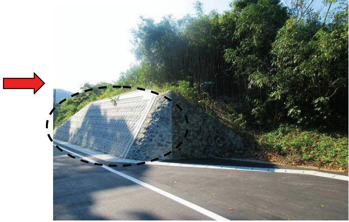
写 4.7 撤去された橋台(残された石積み)
