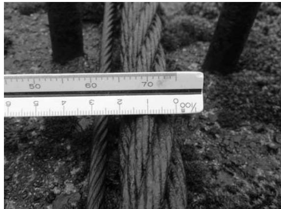
図-14 メインケーブルの腐食状況
