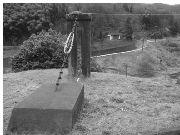
図-6 アンカーブロック・門柱
