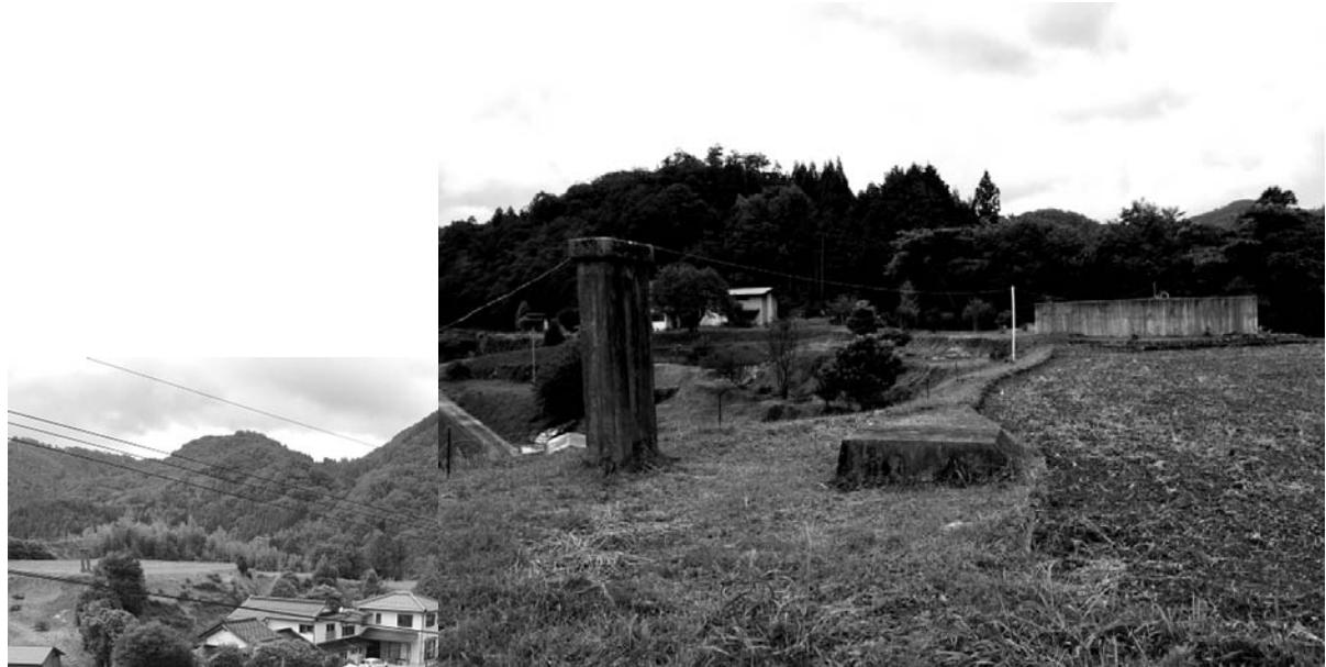
図-20 貯水槽と、左岸に残ったアンカーブロックと門柱
