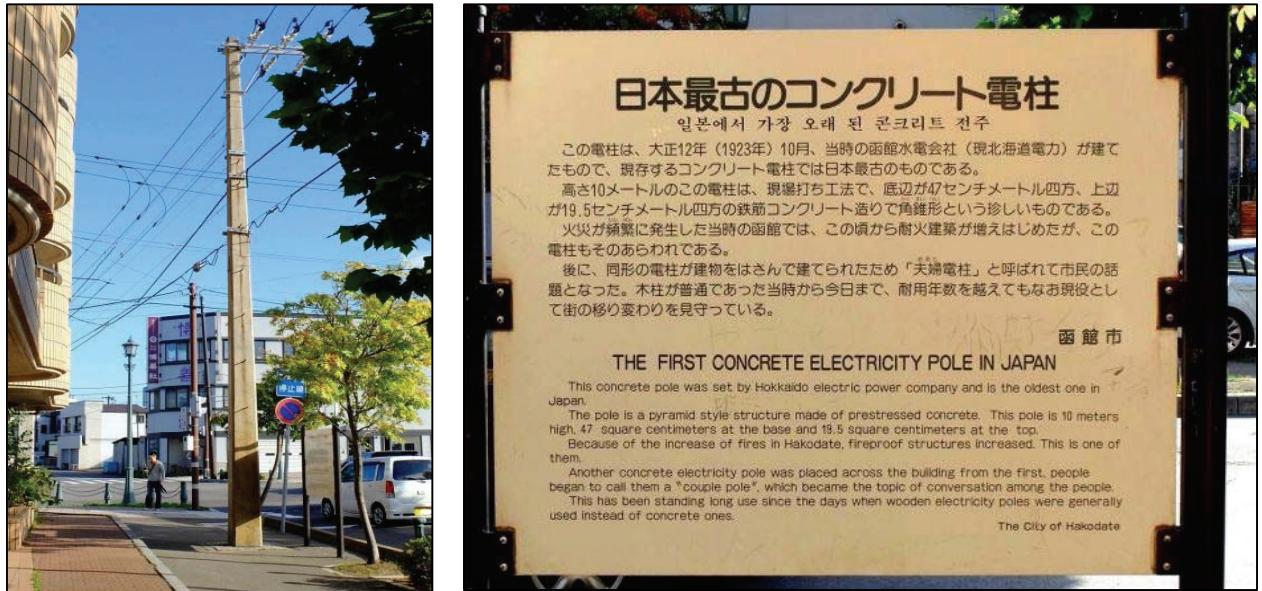
図 4-1. 函館市の四角錐コンクリート電柱（函館市 HP より）
