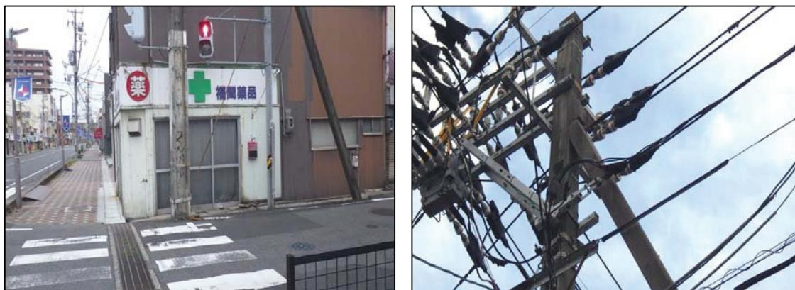
図 4-3. 本柱・控え柱の側面状況と頭部の接続状況
