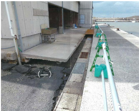
写真-6 波根東漁港の液状化被害
