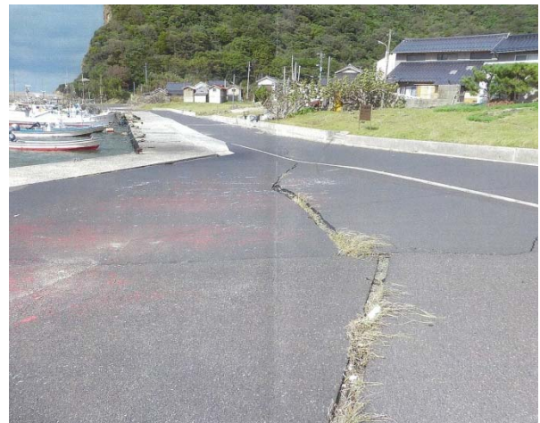
写真-6 波根東漁港の液状化被害
