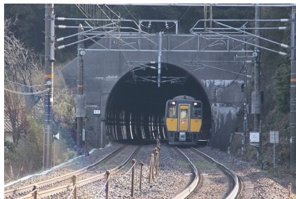
写真 6 来待トンネル（複線型）
