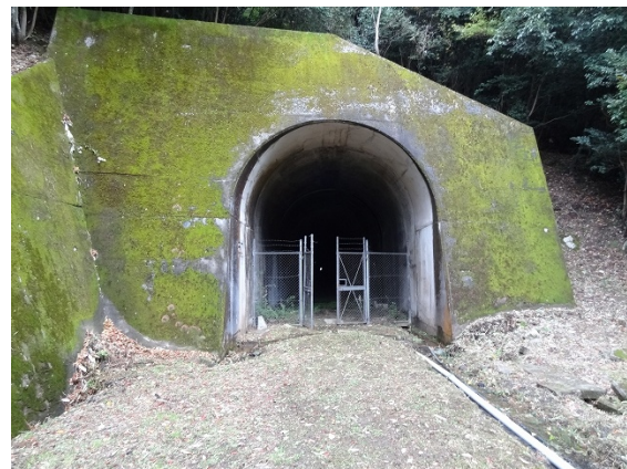
写真 4 佐野側断面（側壁が垂直）
