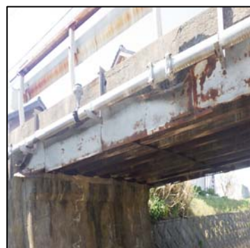
(図 6-2. 主桁側面の水よけ施設と施設状況)
