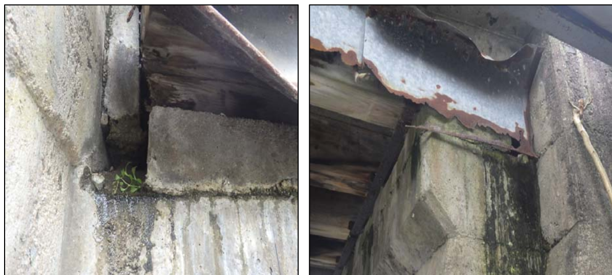
図 6-4. 橋台桁座部の段差と排水溝
