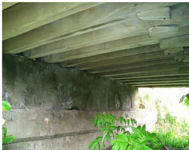
写真-2 構造は矩形に製材された木桁を並べた簡単なもの。しかし、無筋コンクリート床版との接合面に秘密がある。
