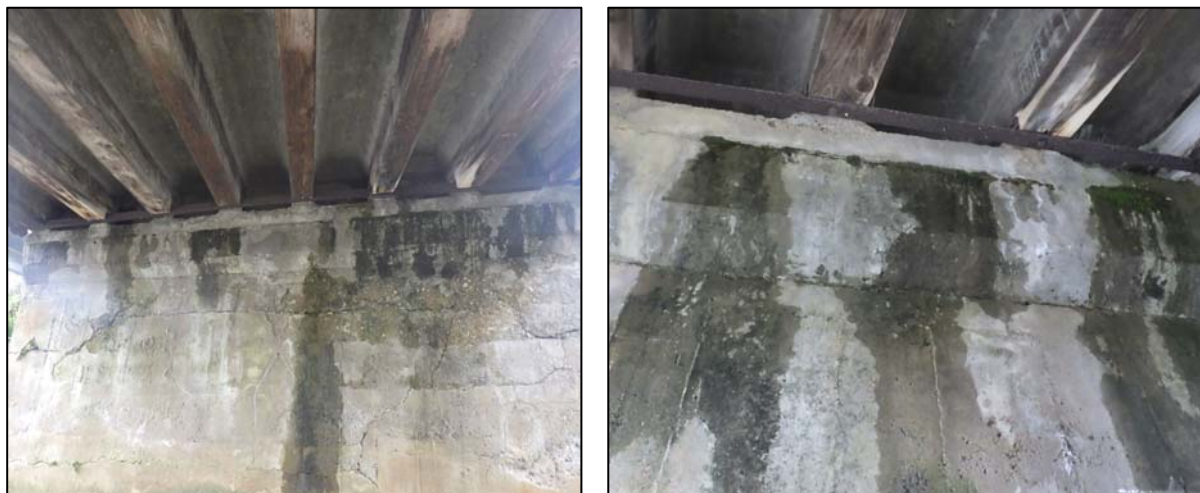
図 6-3. 橋台桁座部の段差構造
