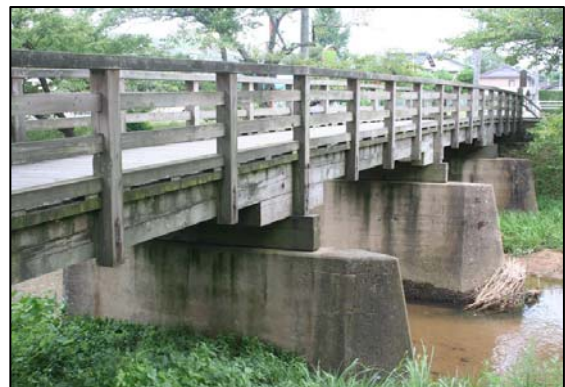
图 5-11. 玉湯川 堂桁橋 (歩道)
