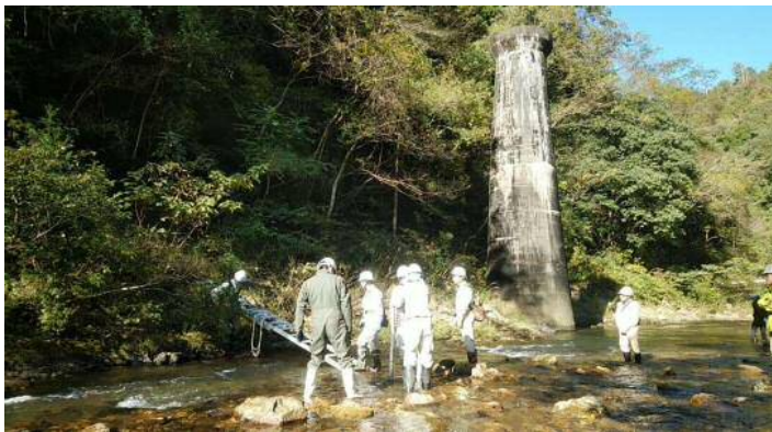
有福第4トンネルへ発見への川渡り
