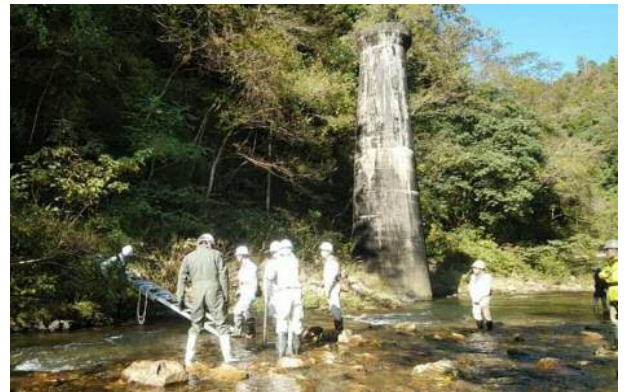
※有福第4トンネル発見への川渡り
