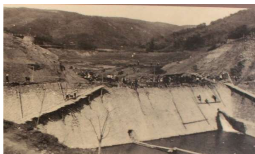
写真 1-3 建設中のダム
