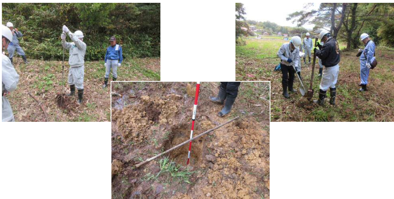
図 3.1.4 簡易貫入試験、天端深さ、試掘状況
