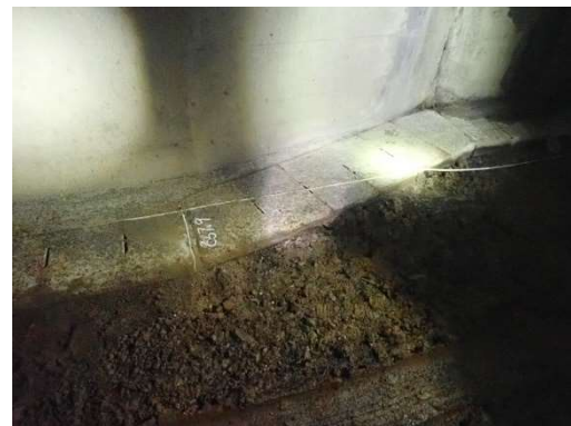
写真-4 トンネル断面変化位置
