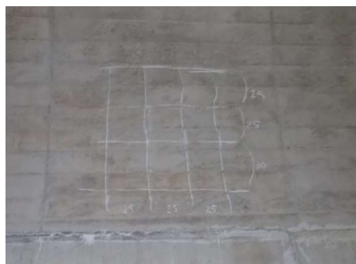
写真-6 鉄筋探査結果をコンクリート面に記入 鉄筋間隔 25～30 cm程度
