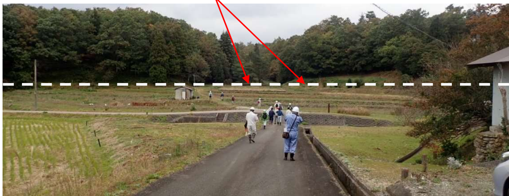
写真-3 現在の状況(土かぶりが薄い谷部)
