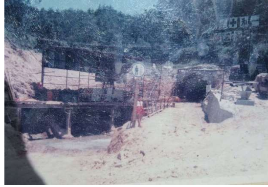
写真-2 トンネル建設時 今福側坑口
