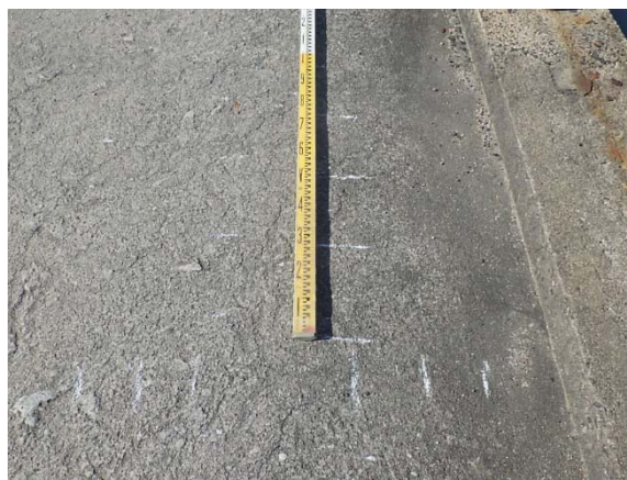
図 4-8. 主方向鋼材分布
