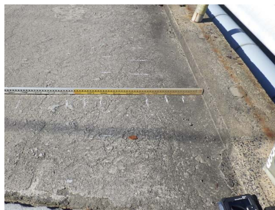
図 4-10. 橋軸方向鋼材分布-2
