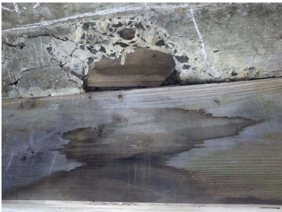
図 4-2. ハンチ欠損部全景
