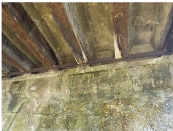
図 4-4. 床版状況（端支点部）
