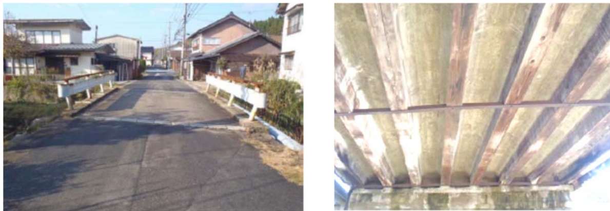
図 1-1. 浜田橋の状況
