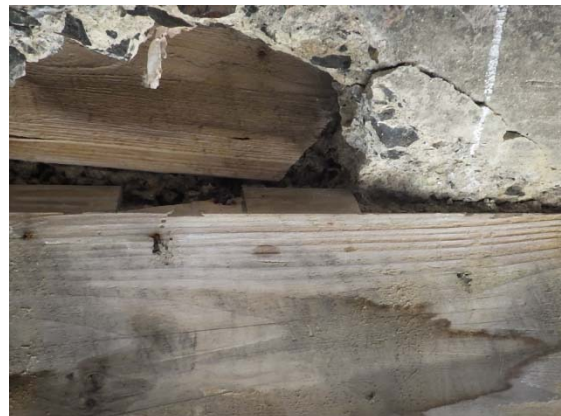
図 4-3. 主桁上面近景
