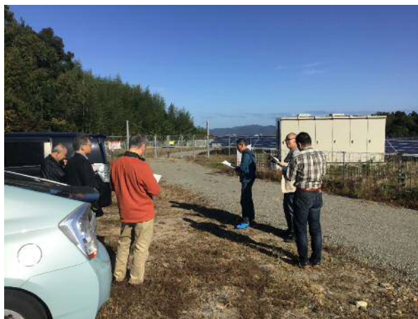
松江市太陽光発電所
