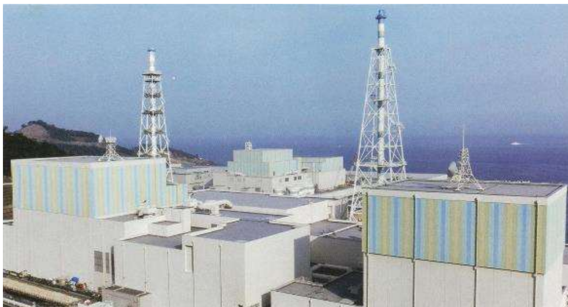
島根原子力発電所 1号機（手前右側）、2号機（手前左側）、3号機（奥側） （中電パンフより）
