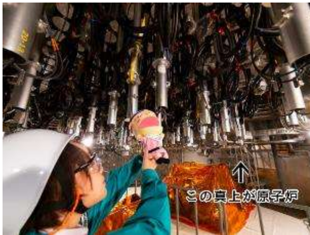
原子炉直下にある制御棒（3号機）
