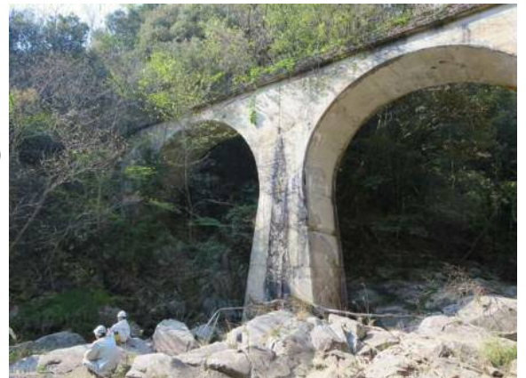
※第一下府川橋梁より旧線の4連アーチ橋
