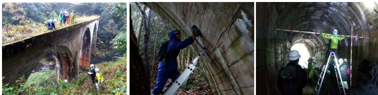
図 3.1.2 現地計測状況
