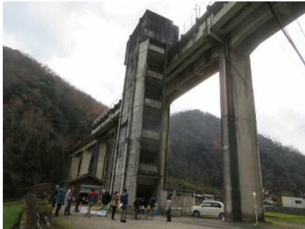
宇都井駅(全景)と高架橋
