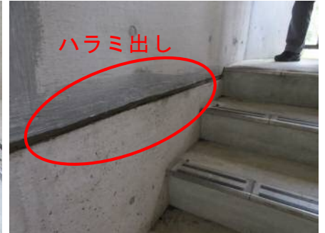
施工目地部でのハラミ(約2cm)
