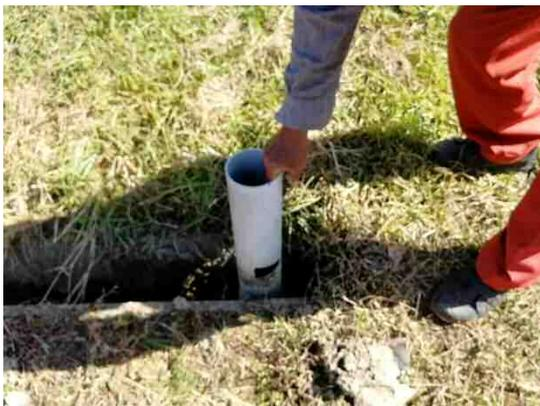
写真-12 「排水溝よけじ」流末部に設置されたパイプ
