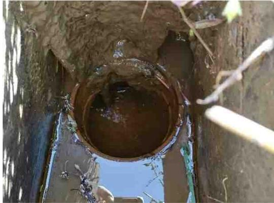
写真-14 「排水溝よけじ」の流末の水平部とエルボパイプ
