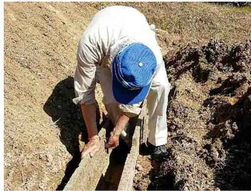
写真-6 排水溝の水路底から約 8cm の位置に開いている穴（ $\phi 25\text{mm}$ ）
