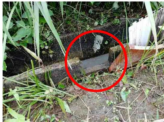
写真-8 欠けた排水溝を修繕し
