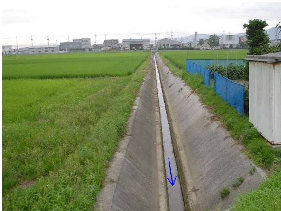
写真-12. 土地改良後の排水路 上面幅 B=500
