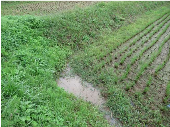
写真-7. 土水路の水たまり
