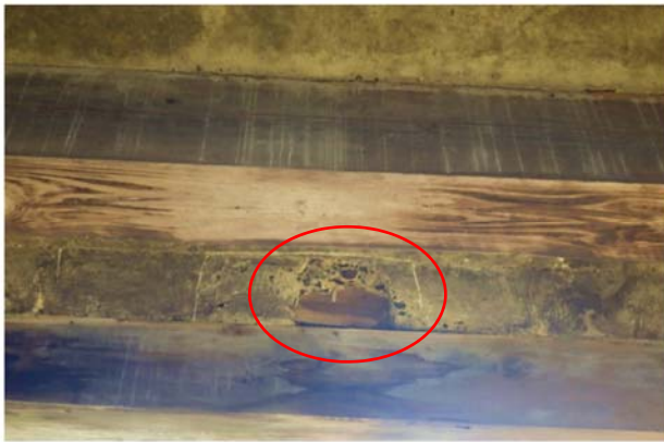
図 2-2. ハンチの損傷 (Pht)
