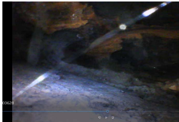
図 3-3. 隙間の内部状況 (CCD 写真)
