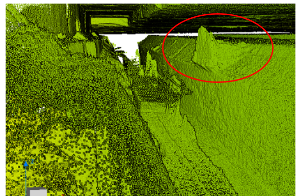
図 2-4. ハンチの損傷 (3D 桁端部から)
