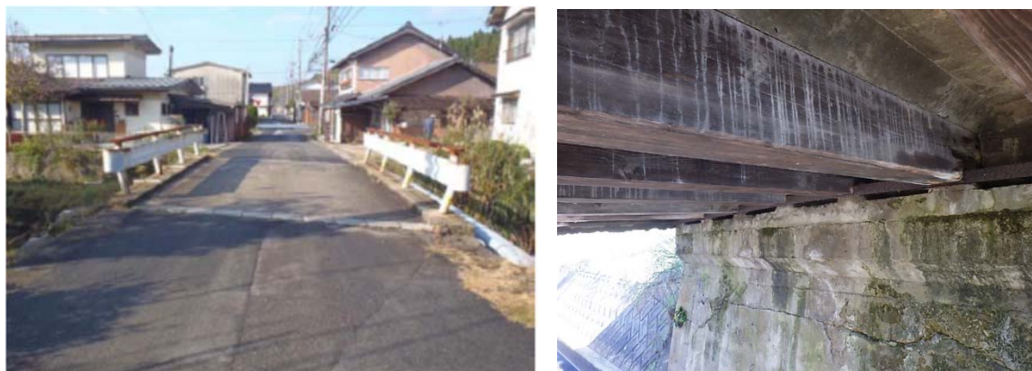
図 1-1. 浜田橋の状況
