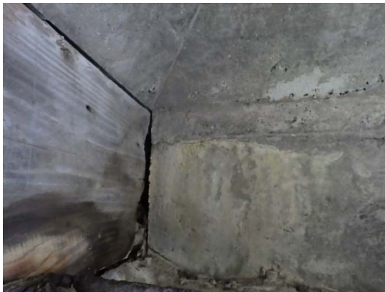
図 3-2. 端横桁と主桁の隙間 (写真)
