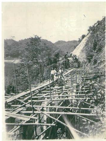
おろち泣き橋 工事現場
