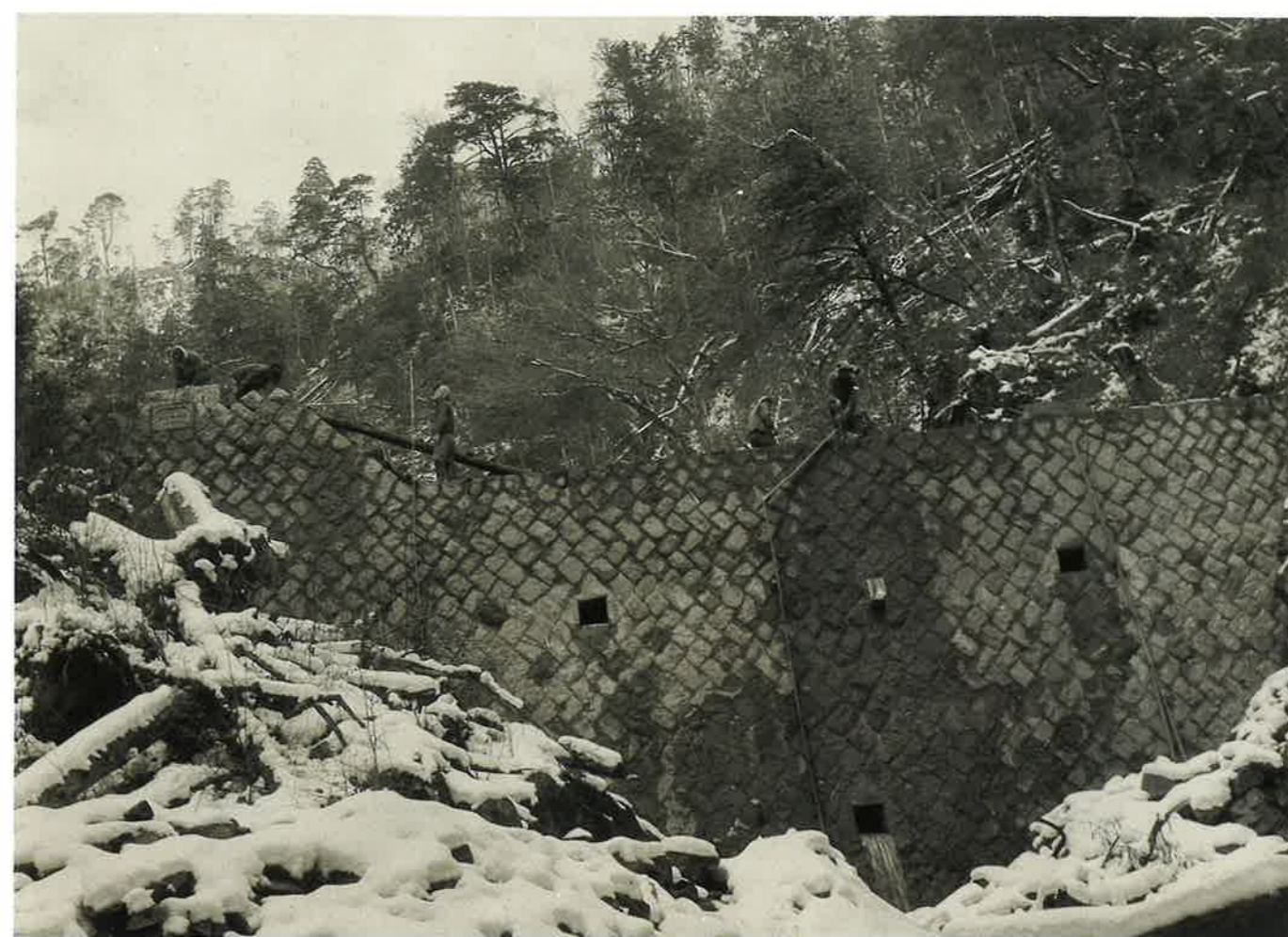
練積堰堤(鈴ノ大谷国有林58林班)体積542.3m 3 、堤長19m、堤高10m。 昭和初期に造られた練積堰堤。石は現地で石工が切り出したものを使用し、職人が一つ一つ積み上げていた。
