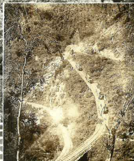
⑤鈴ノ大谷には、林道鉄道が延長7km余り敷設され、トロッコによって栴谷工場まで運搬していた。
