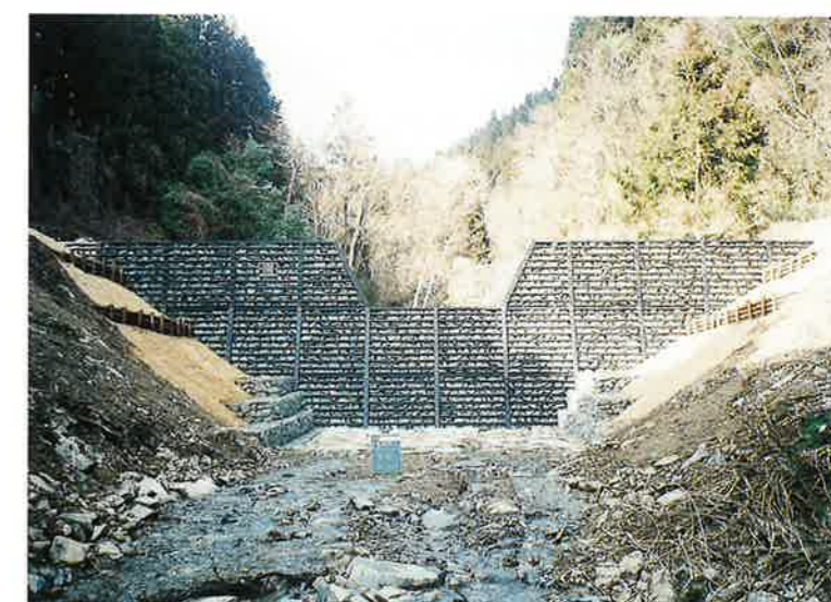
鋼製谷止(栴谷山国有林79・80林班) 平成14年度に設置。谷止の構造は、谷筋に生息する魚類・その他水生動物に影響の少ない、鋼製自在枠谷止とした。
