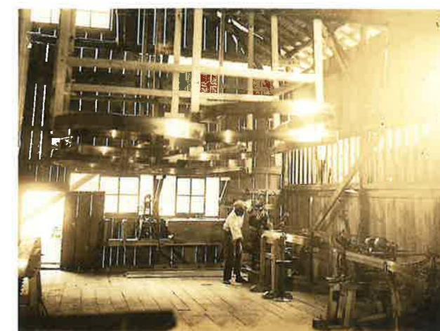
栴谷製材工場 内部
