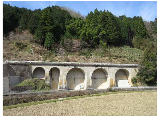
※県道として利用している旧線の5連アーチ橋
