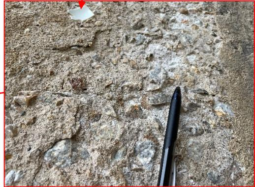
写真-7 表面はく離に伴う骨材露出部
