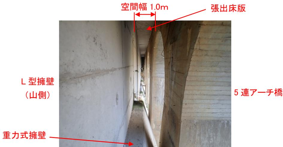
写真-5 アーチ橋の裏側と山側の重力式+L型擁壁の空間
