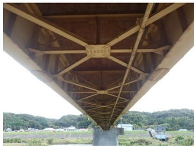
桁下状況 (2主鉄桁)
