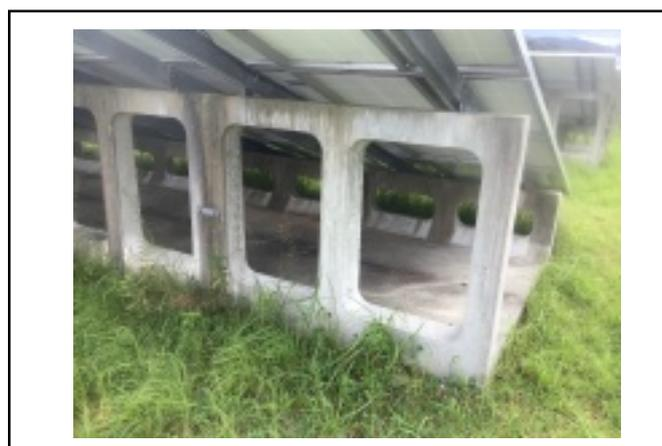
写真10 架台（太陽光パネルの基礎）
