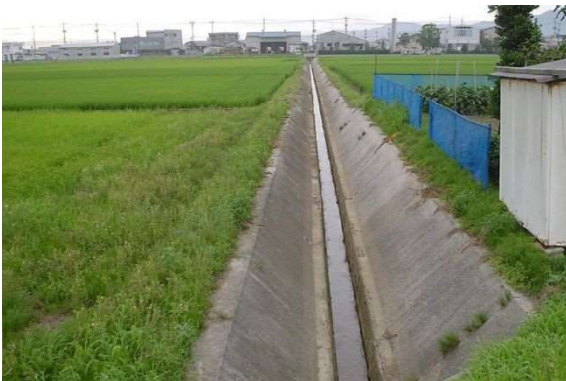
写真-7. コンクリート水路・平常時
