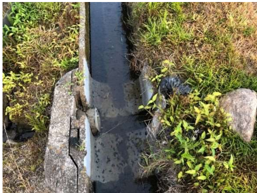
写真-17. 水田の取水口
