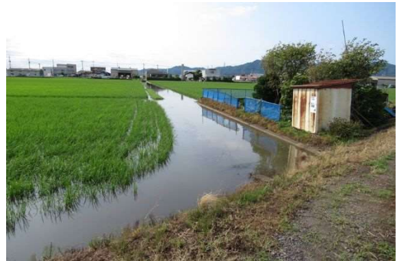
写真-8. コンクリート水路・洪水時(2021.07)
