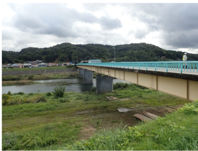
向横田大橋上流側
