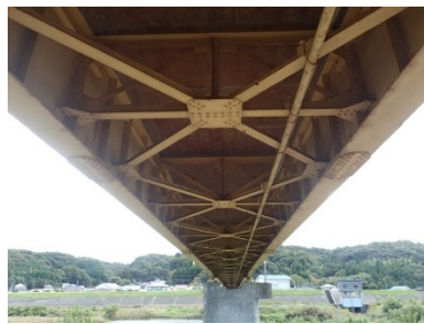
桁下状況 (2主鉄桁)
