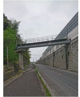
国道部の水管橋
