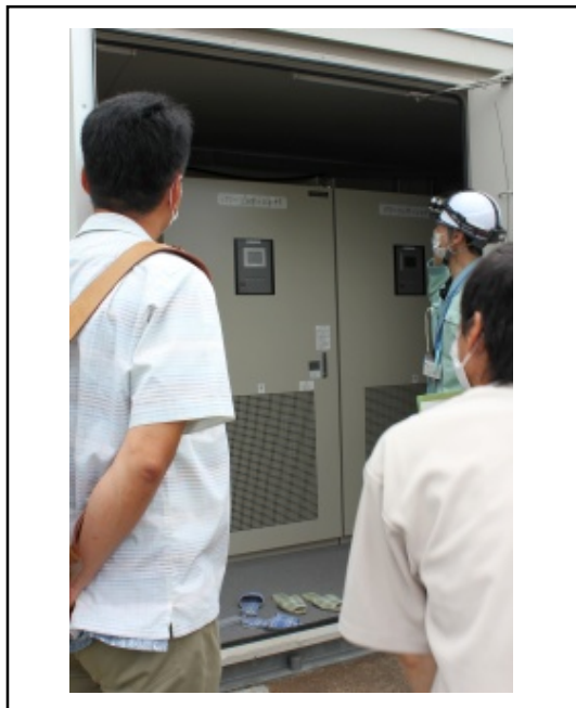
写真12 パワーコンディショナー (室内)
