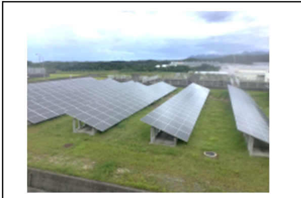
写真4 太陽光パネル（前面側） パネルは南東を向いている
