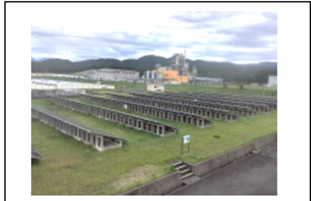
写真5 太陽光パネル（背面側） パネル角度は 15^\circ \sim 16^\circ
