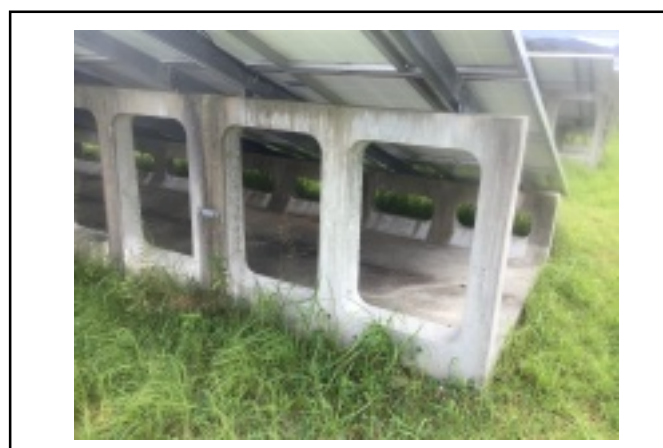
写真10 架台（太陽光パネルの基礎） （プレキャストコンクリート製）
