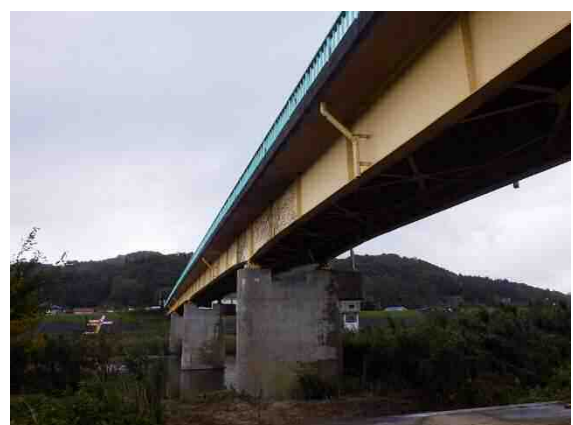
向横田大橋（下面より）
