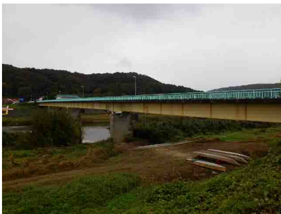
向横田大橋（全景）
