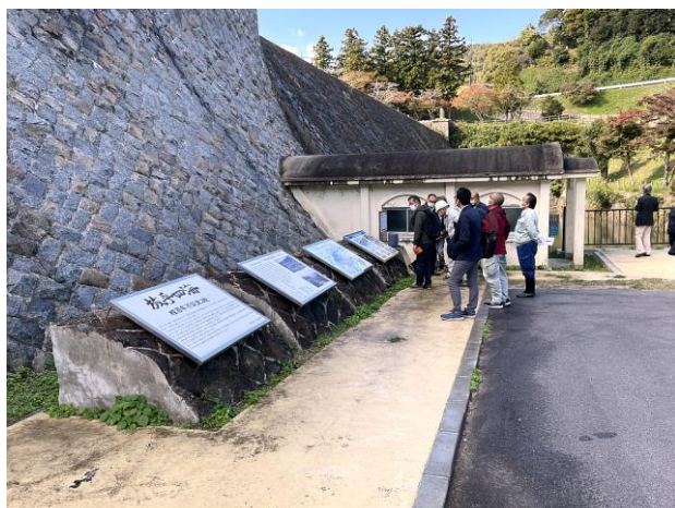
撤去した頂部
