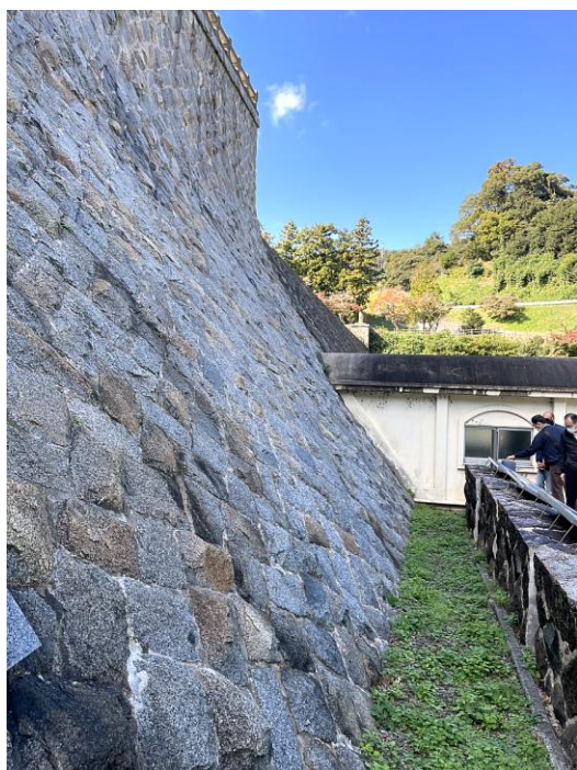
堤体表面（谷積み）
