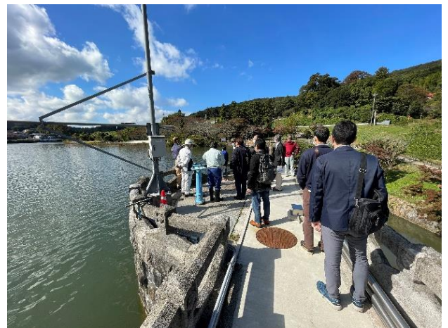
現地視察（千本ダム堤頂）
