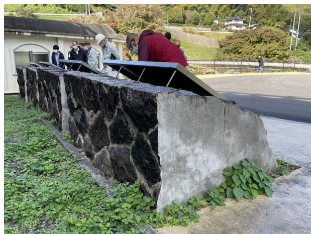
撤去した頂部
