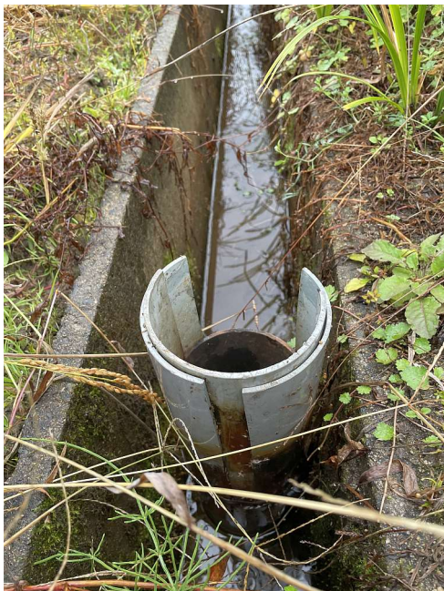
終端の接続：パイプ付替タイプ (容易にパイプが取替可能)
