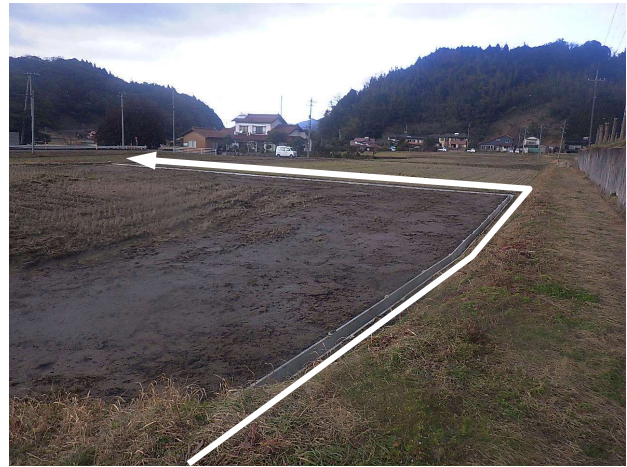
設置直後の排水溝よけじ (水路天端田面+7cm、水平勾配)
