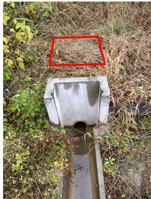
終端の接続：落水口タイプ (奥のボックスは水位制御用)
