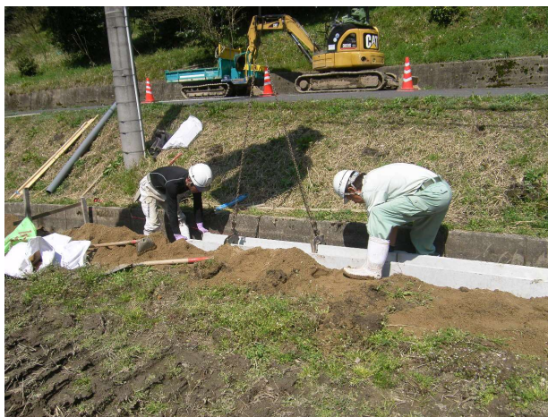
排水溝よけじの布設状況
