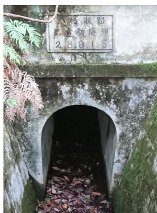
1号水路隧道起点
