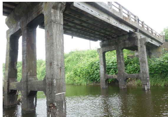
歌越別橋-2（桁は継桁構造）
