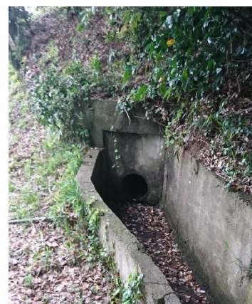
2号水路隧道終点
