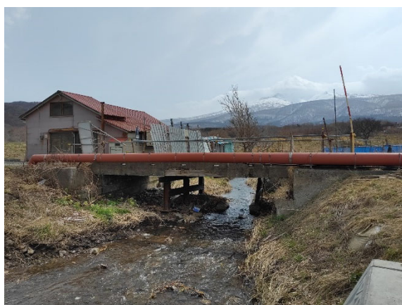
積丹野塚-1（仮設橋脚設置）
