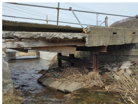
積丹野塚-2（上部工の崩壊）
