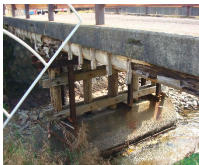
礼髭橋（主桁・橋脚）
